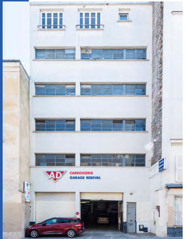
Transformation d'un garage au 77 rue Rébeval (75019) en 7 logements BRS et locaux d'activités
