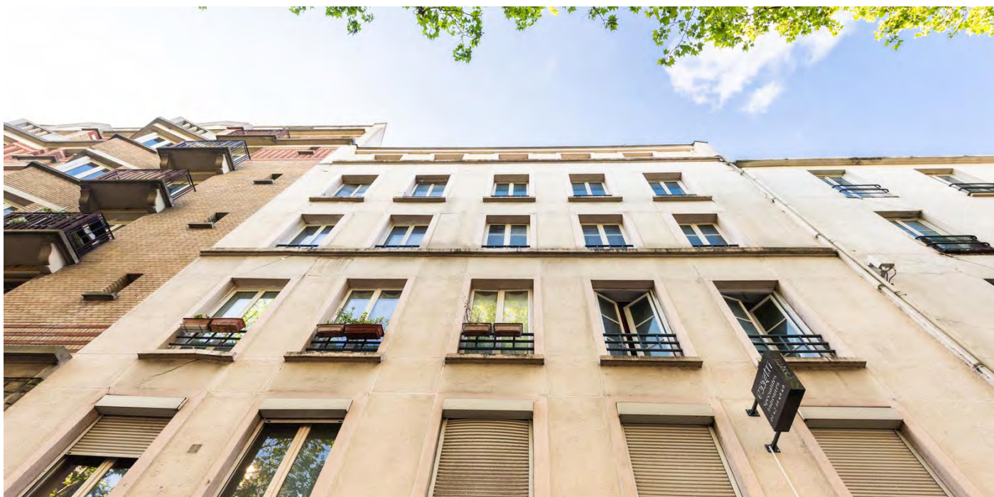
Façade de l'immeuble du 42 avenue Jean-Jaurès (75019) frappé d'un arrêté d'insalubrité
